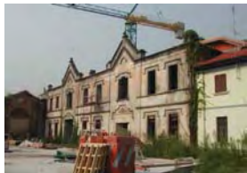
Particolare di facciata
