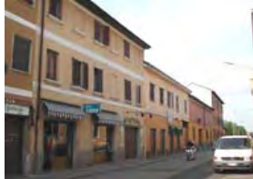
Vista del fronte da sud-ovest
