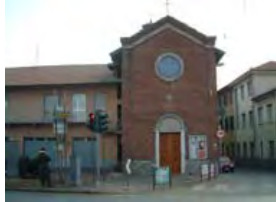
Facciata con ingresso principale sulla via Milano
