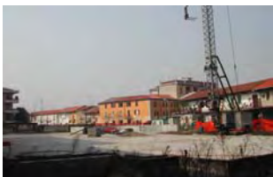
Vista del cortile interno
