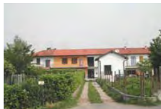
Particolare di facciata dalla via Mazzini
