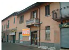
Fronte strada sud-ovest su via Milano
