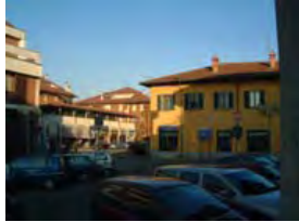
Vista della facciata su corso Italia dalla p.zza Cavour
