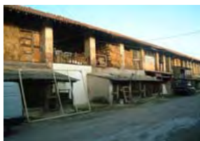
Vista dal cortile delle stalle-fienili
