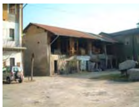
Vista cortile interno edifici accessori
