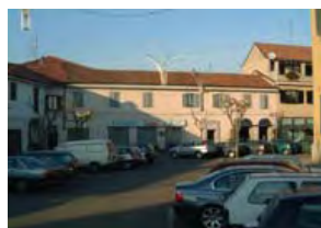
Prospetto della corte su Corso Italia
