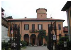
Facciata principale con la torretta quadrata
