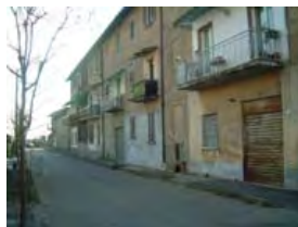
Vista facciata esterna su via Brughiera
