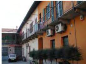
Prospetto del cortile interno
