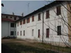
Vista del cortile interno
