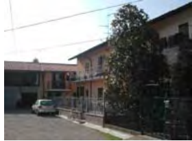
Vista del cortile interno
