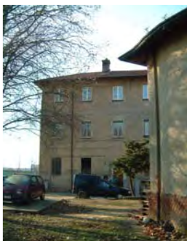
Vista del cortile interno
