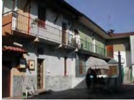
Vista dal cortile interno
