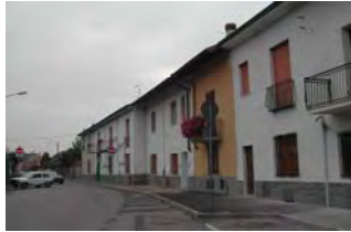
Vista della facciata dall'angolo sud-est
