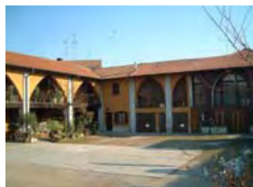
Vista dal cortile interno
