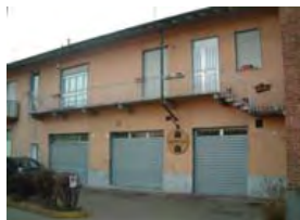
Fronte strada sud-est su via Milano
