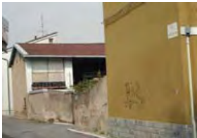
Prospetto su via L. da Vinci con ingresso
