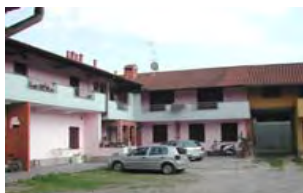
Vista del cortile interno lato residenza
