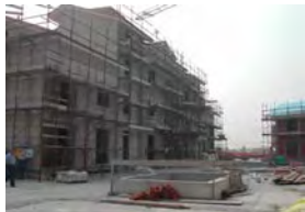
Edificio interno in ristrutturazione
