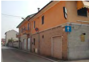
Prospetto dell'edificio lungo via Pezzoni
