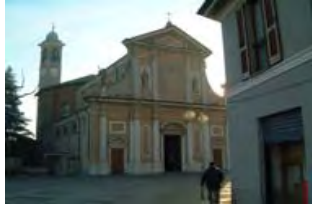
Vista dalla piazza Cavour
