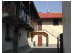
Vista del cortile interno
