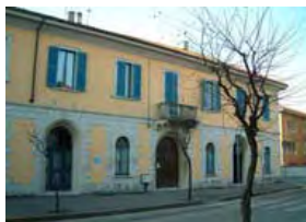
Vista della facciata esterna da via Matteotti
