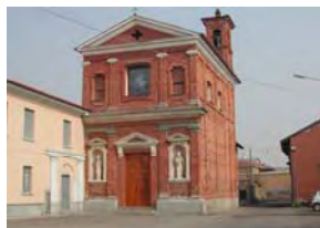
Vista della facciata principale con scorcio della canonica
