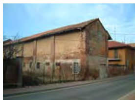
Facciata esterna da via Piave dell'edificio stalle-fienili
