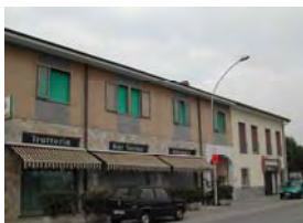
Vista del prospetto su strada da sud-ovest
