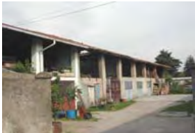
Prospetto interno lato edifici ex stalle-fienili
