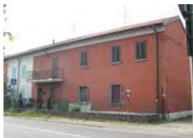
Veduta del fronte dall'angolo nord-ovest
