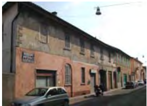
Vista del fronte da nord - est
