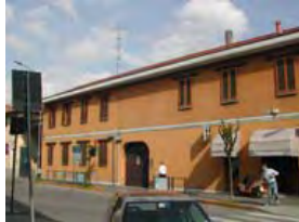
Fronte strada su corso Italia
