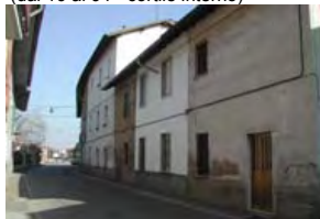
Vista della facciata su strada
