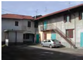
Vista dal cortile interno degli edifici
