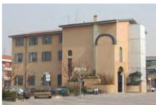
Vista del retro (lato ovest)
