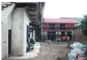
Vista del cortile interno
