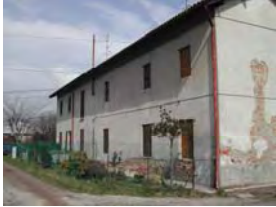
Vista facciata esterna da via Piave
