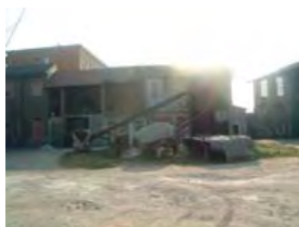
Vista cortile interno edifici accessori
