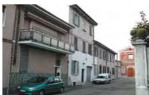
Vista dei prospetti da sud-ovest
