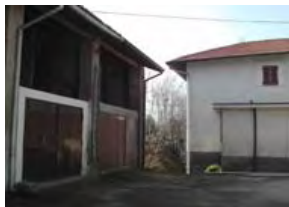
Vista cortile interno edifici accessori
