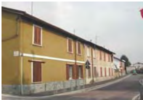
Prospetto su via Matteotti
