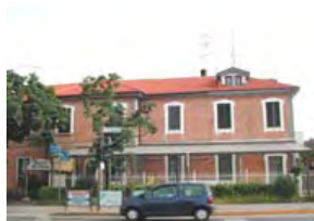
Facciata principale lungo la via Novara
