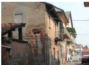
Particolare di facciata
