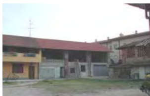
Vista del cortile interno lato ex stalle-fienili
