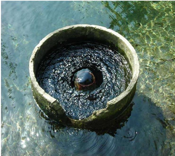
Figura 15 Esempio di polla di un fontanile, costituita da un tino in cemento
