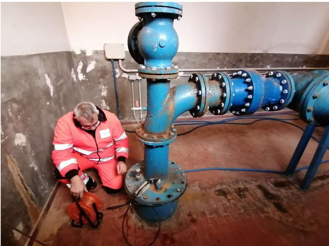
Figura 19 Misurazione del livello statico dell'acqua di falda presso il pozzo 0150120001
