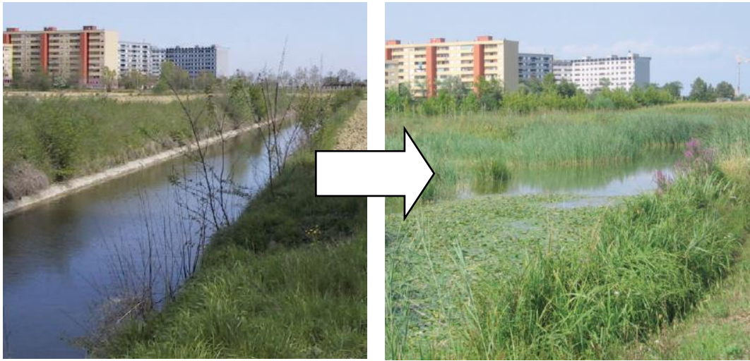
Esempi di riqualificazione di un canale in Provincia di Venezia
