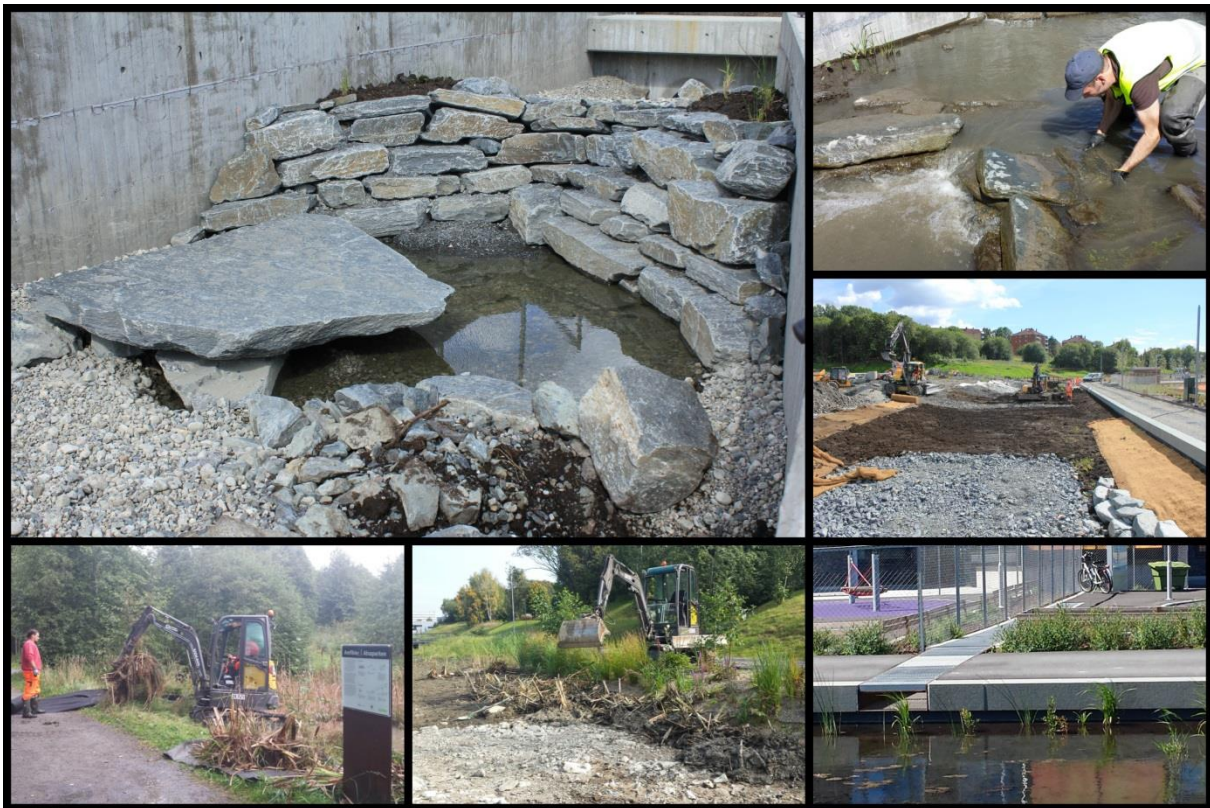
Esempi degli interventi di riapertura di corsi d'acqua tombati ad Oslo
